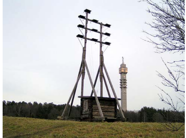
En länk i den optiska telegrafen, rekonstruerad. Metallplattorna som kan var nedfällda eller uppfällda syns i överdelen.
